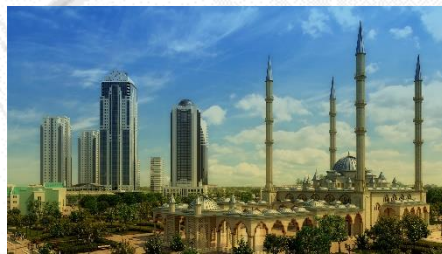
Жилой комплекс «Феникс» г. Грозный, ул. Димаева, 14
